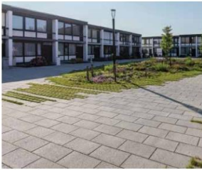
1. Rijbaan grijs betonstraatsteen gesloten Lineo 300x600 mm
